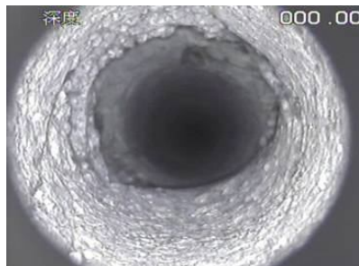
图 1 现场观测的劈裂裂缝现象
